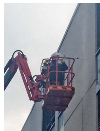
Eine der Aufgaben: Die Reinigung der Kunststeinfassade mit Hilfe des Trockeneisstrahlverfahrens.
