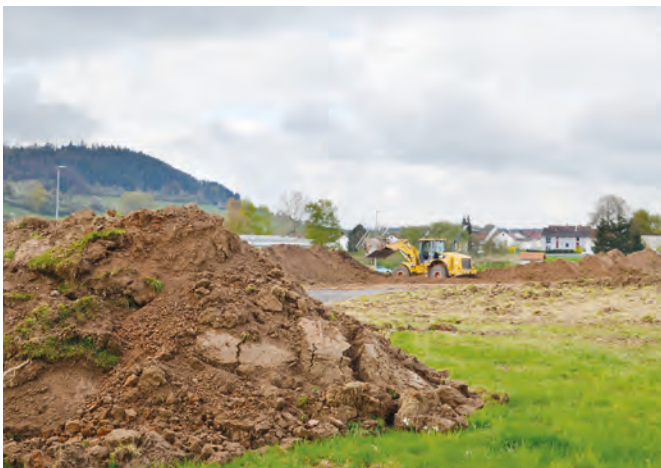
Kurz nach dem Spatenstich rückten bereits die Bagger für den Erdaushub des neuen Zentrallagers an. (Foto: GVS Group)
