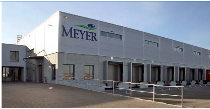
Das neue Service- und Logistikzentrum der Johann A. Meyer GmbH in Wildau.
